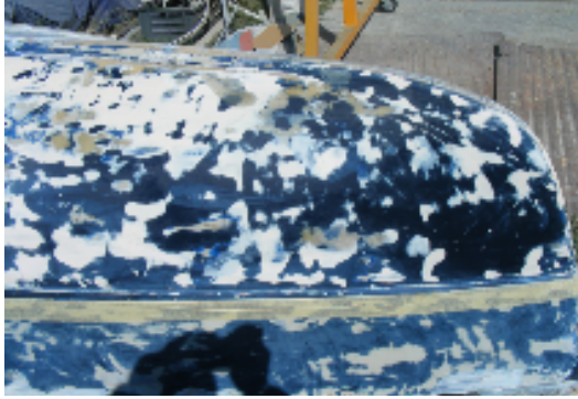
Fig.3. Suprafetele pregatite pentru protejare cu ECOMPUR 28 si 41
